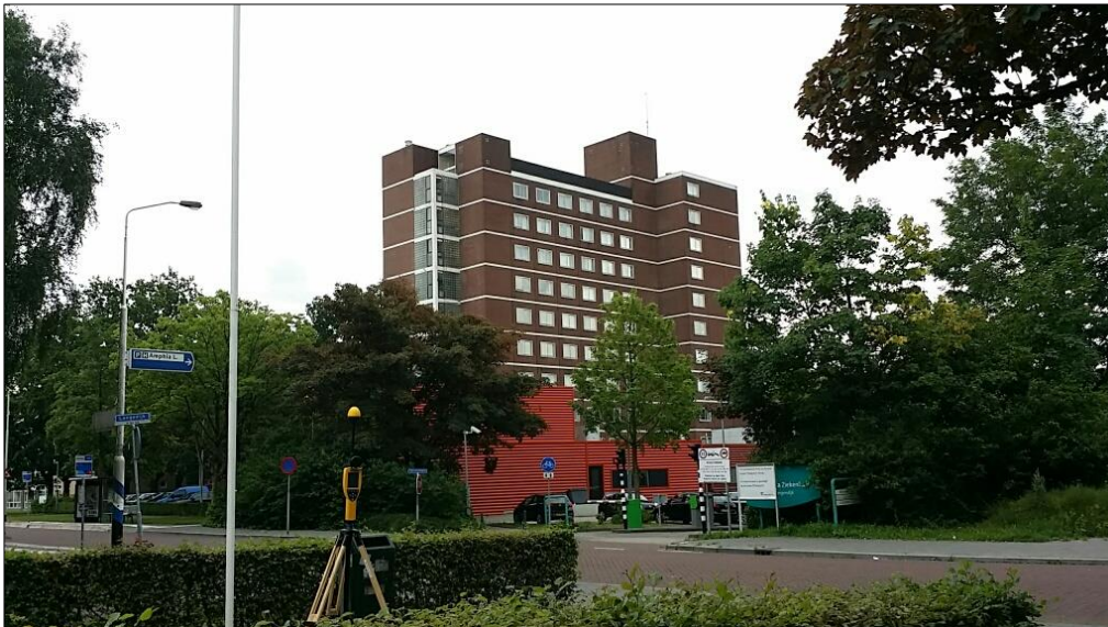
Foto 1: Opstelpunt breedbandige meting Langendijk.
