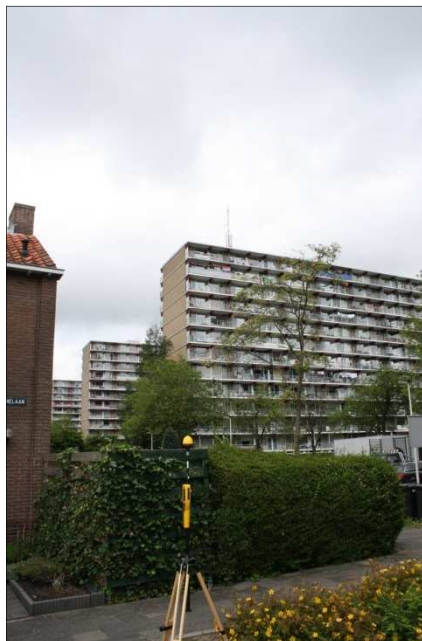
Foto 1: Meetlocatie Zonnelaan te Purmerend
