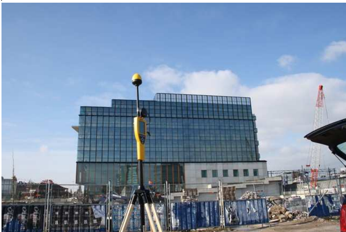
Foto 2; Meetopstelling openbare weg Oosterdokskade – Oosterdoksstraat te Amsterdam.
